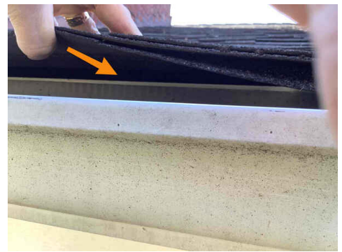
No drip edge on edge of roof decking
